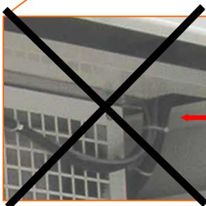
Em seguida, ligue o cabo de alimentação do módulo à rooftop e o cabo Modbus de acordo com o diagrama de ligações do bus (poderia ser ligado ao conector BE (A1) no quadro elétrico da rooftop ou outras opções com comunicação via bus):
