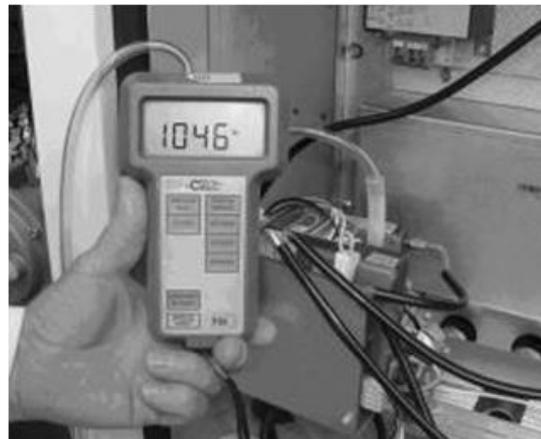
A pressão de saída tem de ser medida na válvula de pressão localizada na barra de suporte do injetor de gás para evitar a perda da pressão devido ao cotovelo a jusante da válvula
